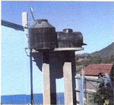
Foto 17: Reparación de cisterna de agua y construcción de tarima de concreto para sostenerla.
