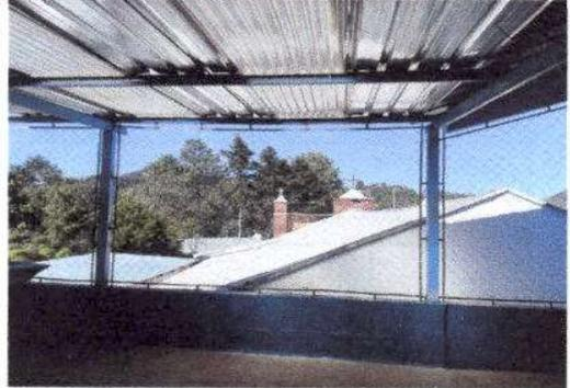
Foto 14: Reparación de muro perimetral con tubo hg y malla galvanizada al lado de cocina 7 metros lineales
