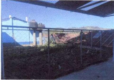
Foto 15: Reparación de muro perimetral con tubo hg y malla galvanizada en frente de los servicios sanitarios 11 metros lineales
